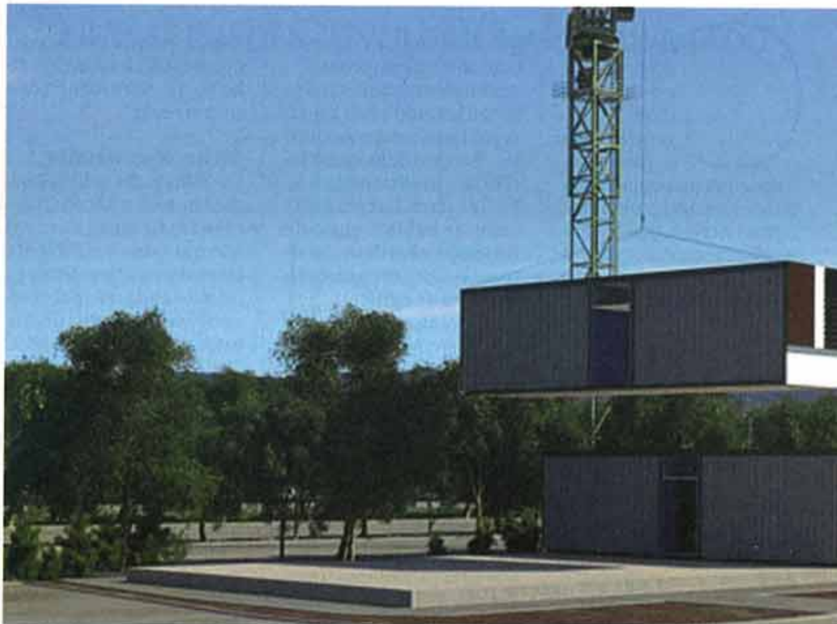
Montaje del I-Sleep de Zaragoza, el primer hotel 'low cost', sostenible y transportable.
