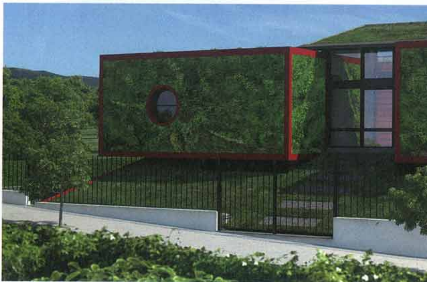
La casa Beardon, de Luis de Garrido, es autosuficiente en agua y energía.
