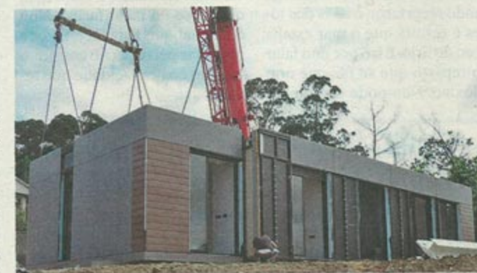
Evolución del montaje de los módulos de la vivienda de Oleiros. A-CERO
